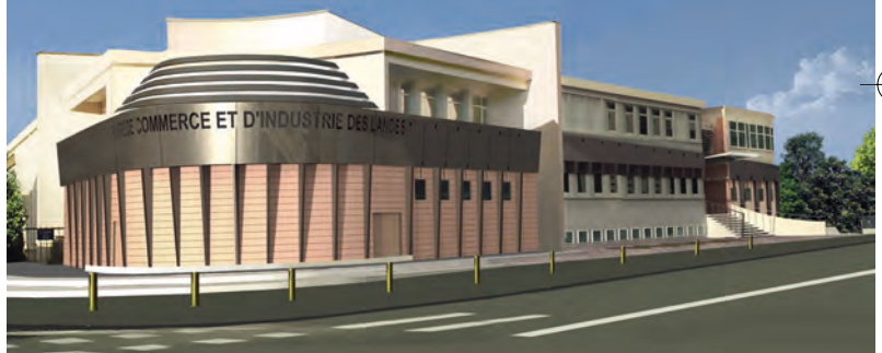
Le parvis et les façades du Centre de Conférences et de Séminaires
