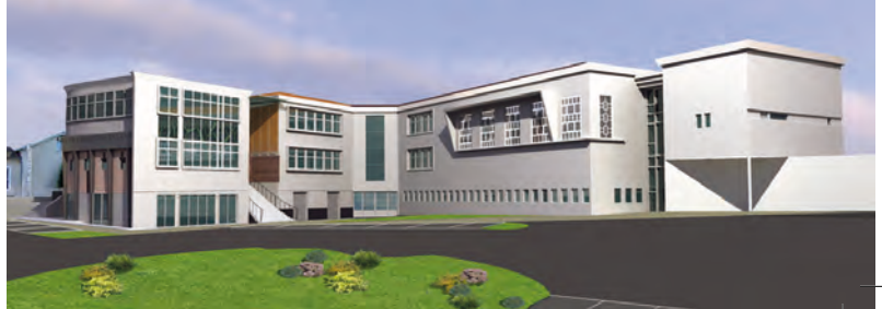
Vue arrière depuis le parking de 120 places
